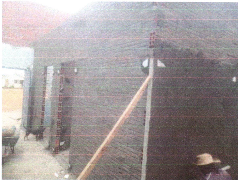
Foto 11 - CHAPISCO APLICADO EM ALVENARIA (COM PRESENÇA DE VÃOS) E ESTRUTURAS DE CONCRETO DE FACHADA, COM EQUIPAMENTO DE PROJEÇÃO. ARGAMASSA TRAÇO 1:3 COM PREPARO EM BETONEIRA 400 L. AF_06/2014
