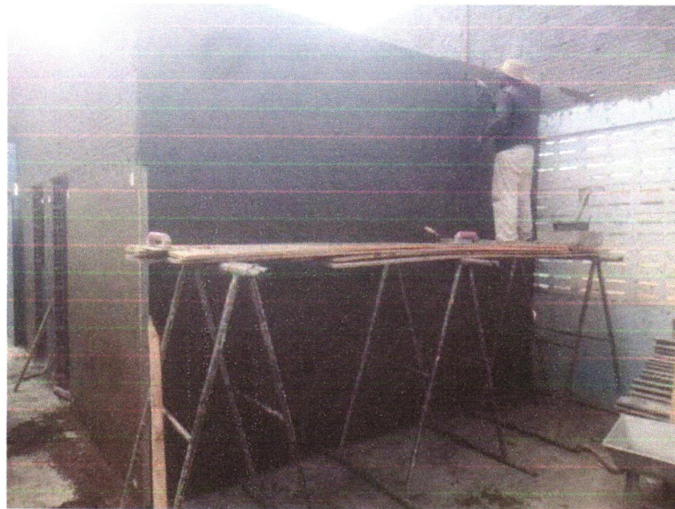
Foto 13 - MASSA ÚNICA, PARA RECEBIMENTO DE PINTURA OU CERÂMICA, ARGAMASSA INDUSTRIALIZADA, PREPARO MECÂNICO, APLICADO COM EQUIPAMENTO DE MISTURA E PROJEÇÃO DE 1,5 M 3 /H EM F INTERNAS DE PAREDES, ESPESSURA DE 5MM, SEM EXECUÇÃO DE TALISCAS. AF_06/2014
