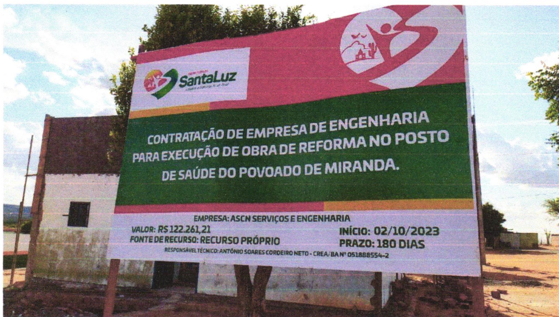
FOTO 01 – PLACA DE OBRA EM CHAPA AÇO GALVANIZADO, INSTALADA - Rev 02_01/2022
