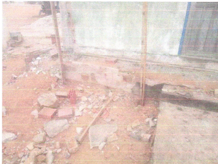
FOTO 04 - DEMOLIÇÃO DE ALVENARIA DE BLOCO CERÂMICO E=0,09M - REVESTIDA
