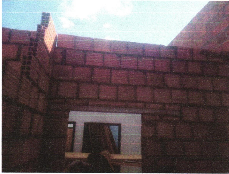
Foto 10 - ALVENARIA DE VEDAÇÃO DE BLOCOS CERÂMICOS FURADOS NA HORIZONTAL DE 9X19X29 CM (ESPESSURA 9 CM) E ARGAMASSA DE ASSENTAMENTO COM PREPARO EM BETONEIRA. AF_12/2021
