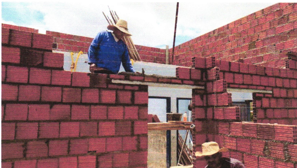
FOTO 09 – ALVENARIA DE VEDAÇÃO DE BLOCOS CERÂMICOS FURADOS NA HORIZONTAL DE 9X19X29 CM (ESPESSURA 9 CM) E ARGAMASSA DE ASSENTAMENTO COM PREPARO EM BETONEIRA. AF_12/2021
